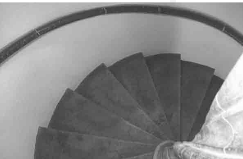
L'ESCALIER EN COLIMAÇON
