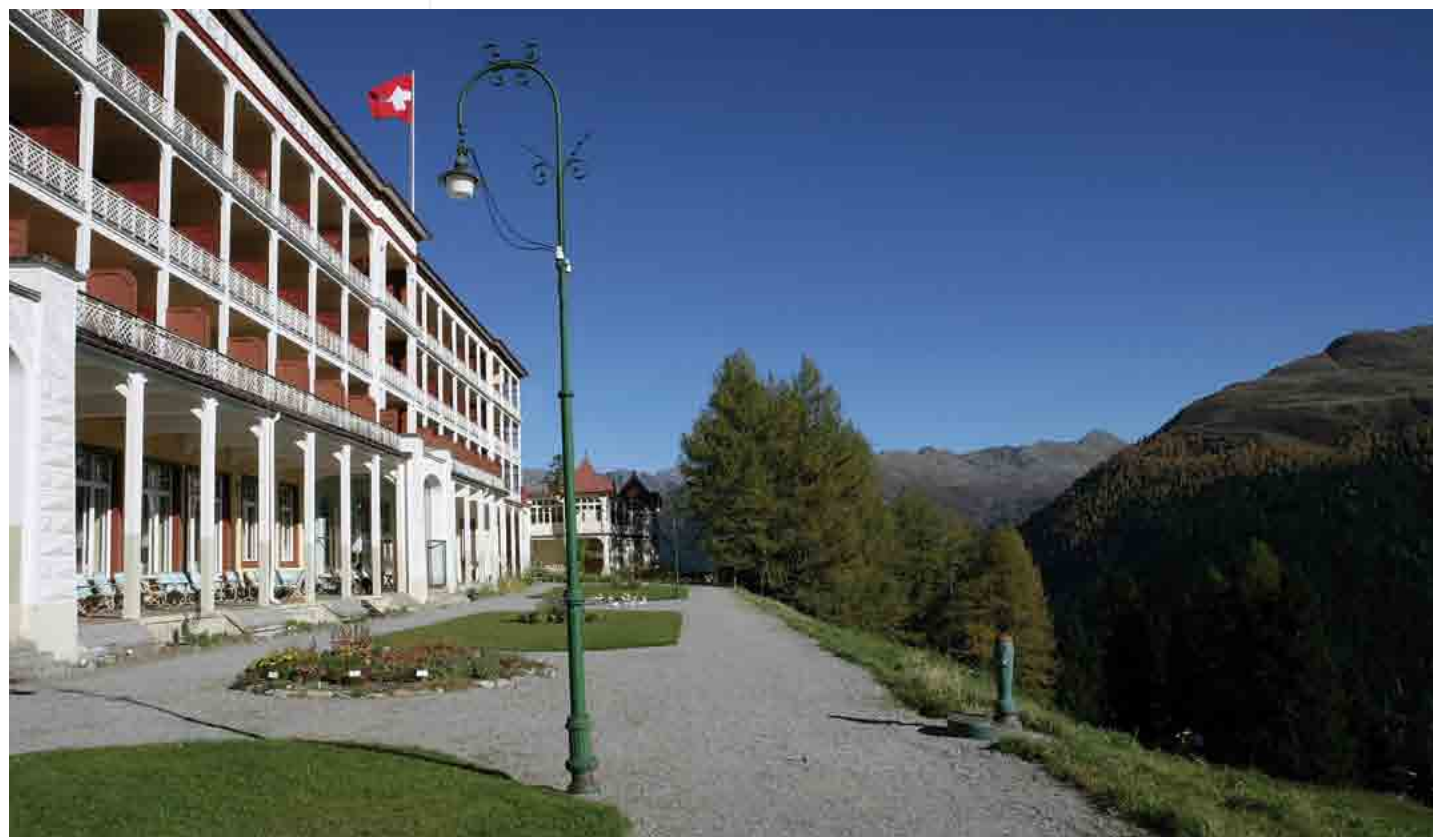
HOTEL SCHATZALP: DAS JUGENDSTIL HOTEL WURDE IN DEN JAHREN 1898 BIS 1900 ERRICHTET UND DIENTE VORERST ALS SANATORIUM. NOCH BIS HEUTE IST DIE SEELE DES HAUSES, DIE ARCHITEKTUR, IN ORIGINALFORM ERHALTEN.
