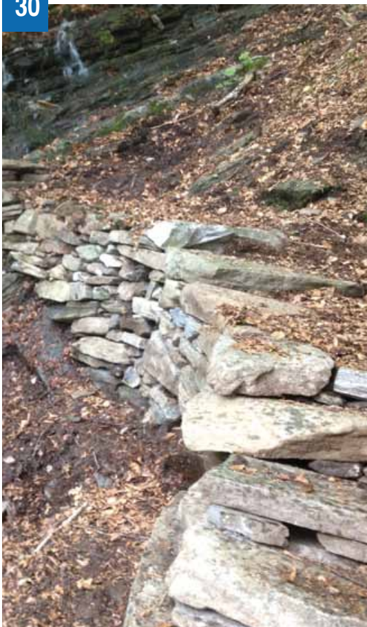
Muro a secco sopra Castello in Val di Lodano
