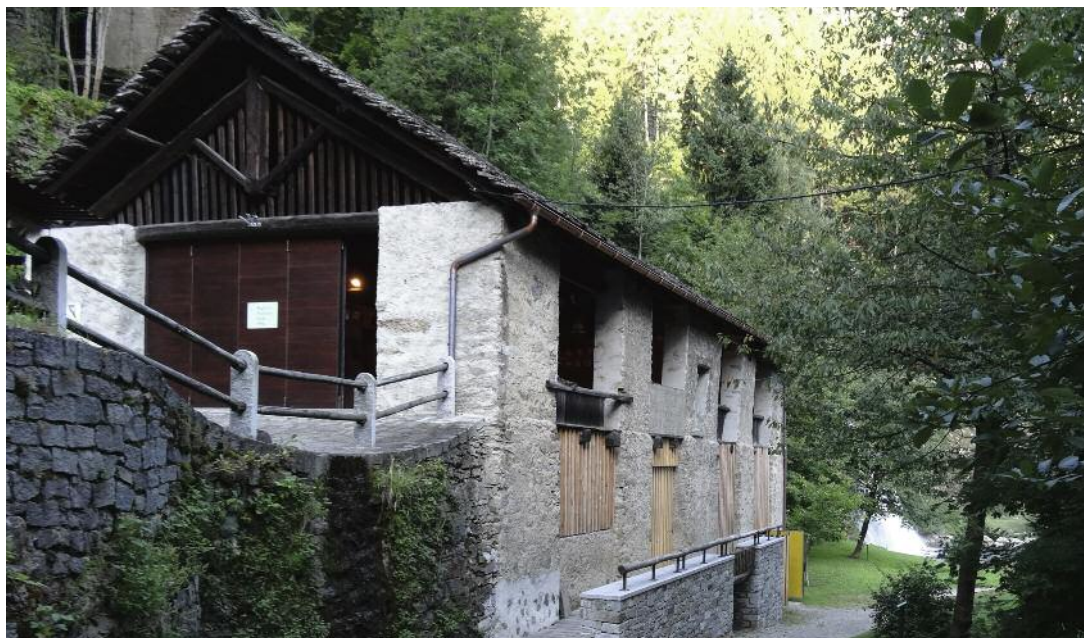
La segheria, unico stabile sopravvissuto della zona industriale della Piumogna.
